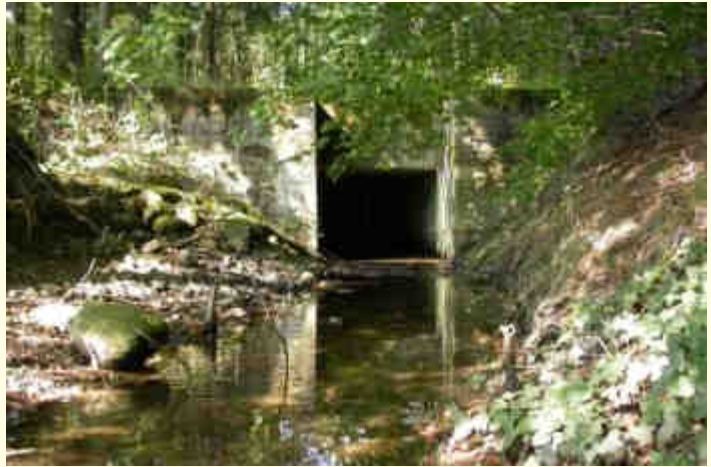
Schiebenitz - "Tunnel" im Riepenholz, August 2006
